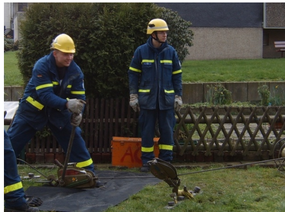
„Erdverankerung unter Greifzuglast“
