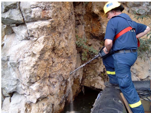
Setzen der Löcher für eine Erdnagelverankerung in gewachsenem Fels
