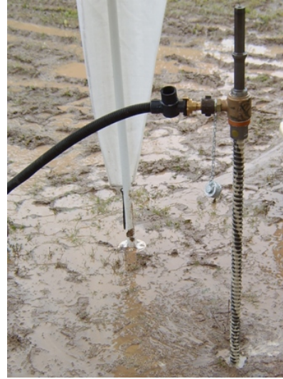
„Injektionsankers wird mit Beton verpresst“
