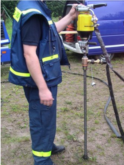
„Einbohren des Injektionserdankers Mittels des Drucklufthammers der FG Räumen, OV Schwelm“
