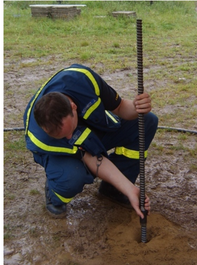
„Verlänger des Injektionsankers“
