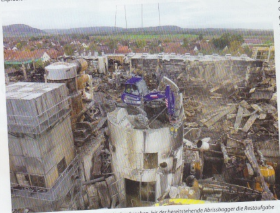
Blick aus der Brandruine auf Silo und Rettungsspinne, die weite Strecken über dem Gefahrenbereich schwebend arbeitete.
