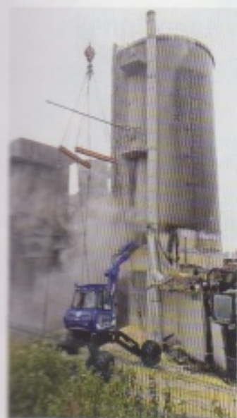
Am Kran gesichert öffnet die ERS den Brandherd
