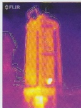
Die Wärmebildaufnahme des THW - Fachberaters zeigt den Schwelbrandherd im unteren Drittel des Siloturmes.
