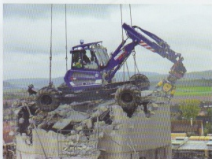
Der stark armierte Silodeckel leistete über mehrere Stunden Widerstand. Mittels Hydraulikmeißel und Betonknabber konnte er schließlich entfernt werden.
