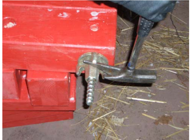
Festziehen einer Flanschmutter mit einem Zimmererhammer (Bild OV Remscheid)
