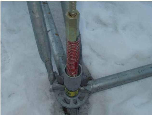
Sicherung einer EGS-Konstruktion mit einem Ankerstab als Erdanker (Bild OV BGL)
