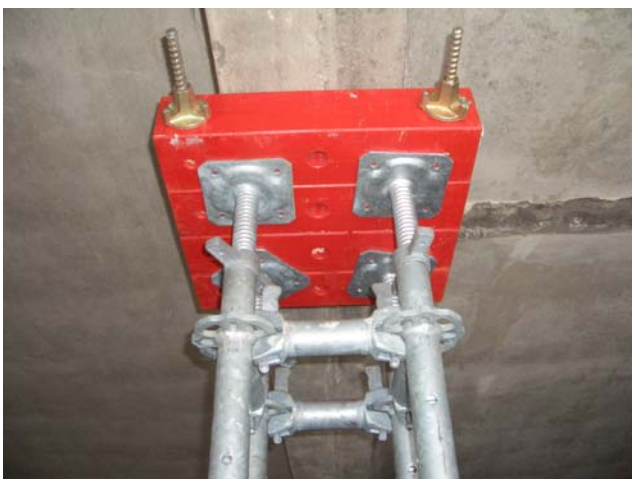
Mit Ankerstäben zu einer Platte verschraubte Rüstholzer (Bild BUS Hoya)
