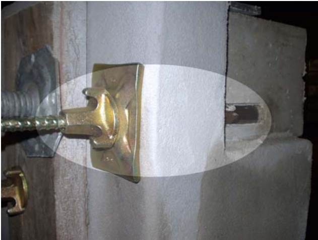
Demonstrations-Wandanker mit seitlich aufgeschnittenem Bohrloch (Bild OV BGL)
